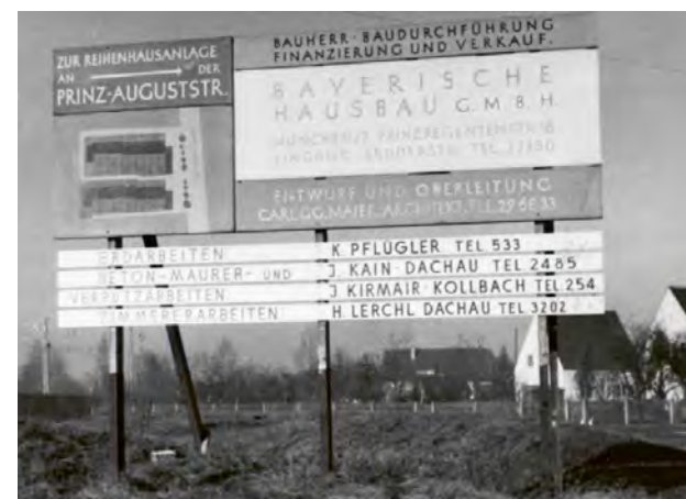
Damals wie heute für jede Baustelle unverzichtbar: die Bautafel.
