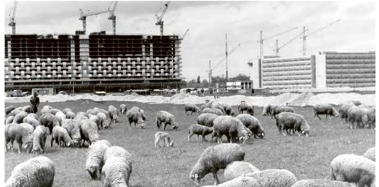
Schafwiese vor der Großbaustelle des Arabellahauses.
